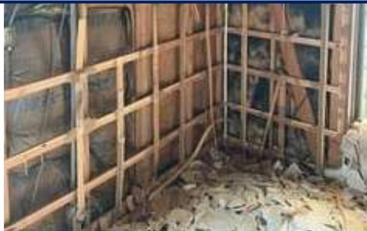
結露で機能を果たしていない断熱材
